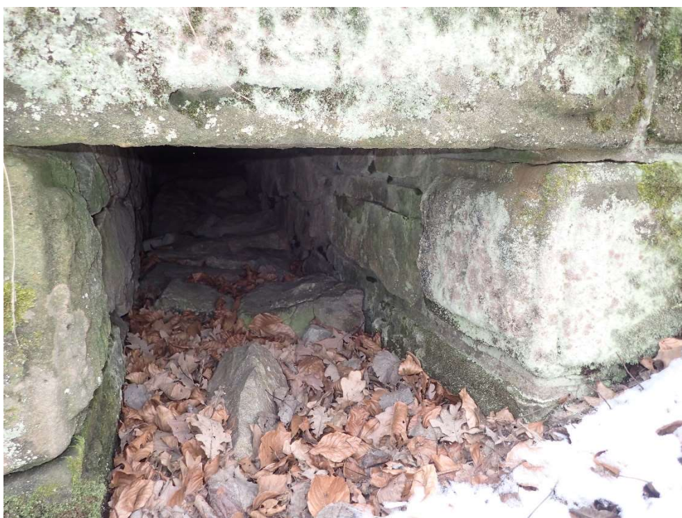
Foto 4: Pohled do propustku - uvolněné kameny, místy vypadané spárování
