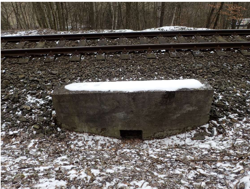
Foto 1: Pohled na výtok propustku
