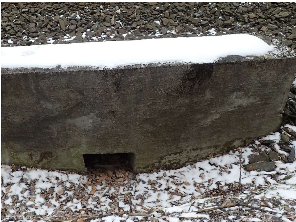
Foto 3: Na čele propustku místy opravené trhliny
